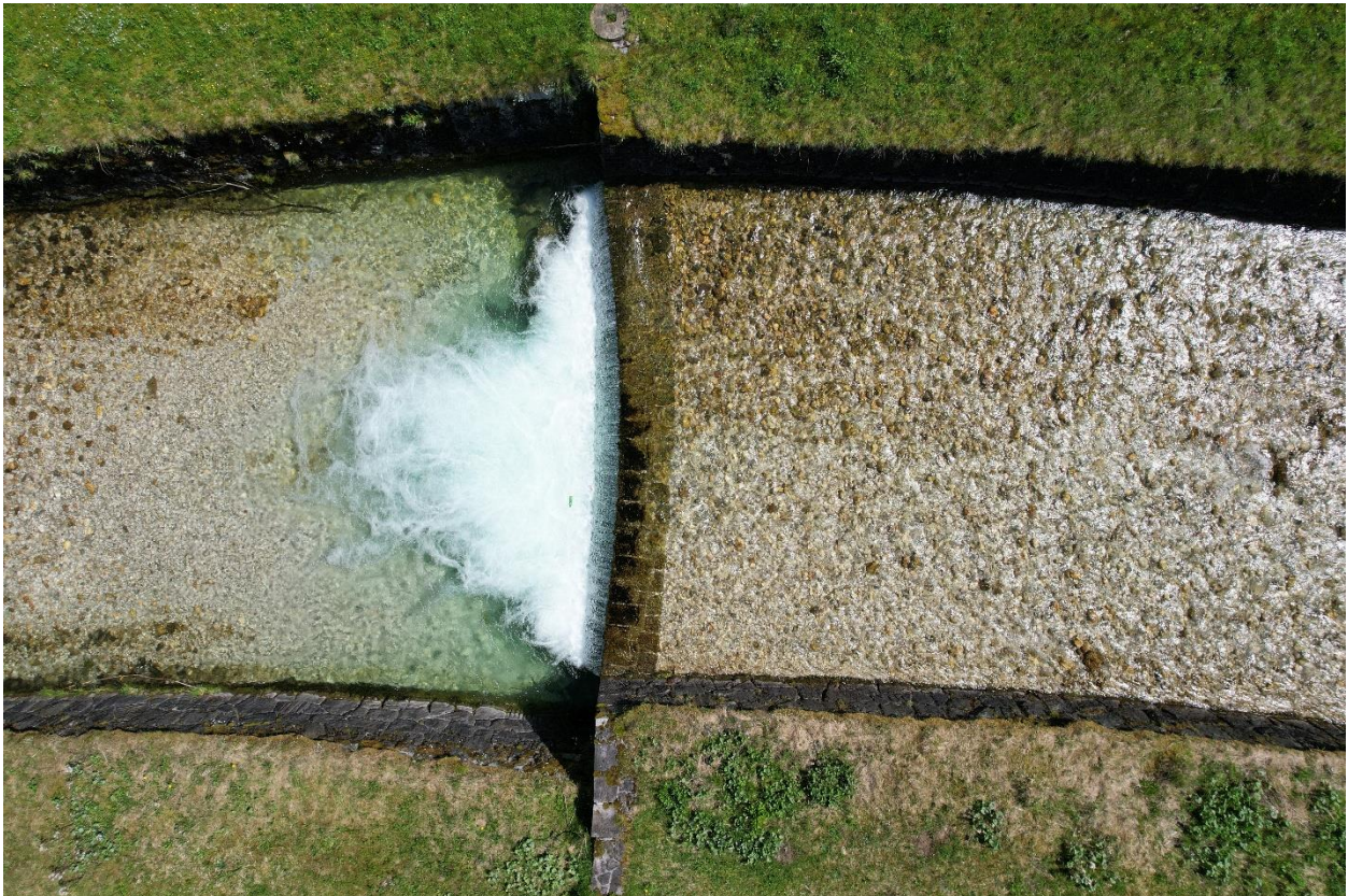
Abb. 1 Wenn ein Querbauwerk den Fluss unterbricht, sein Bett befestigt ist oder seine Ufer begradigt und verbaut sind, kann er nicht frei fließen. © L. Kirchgässner, blattfisch
